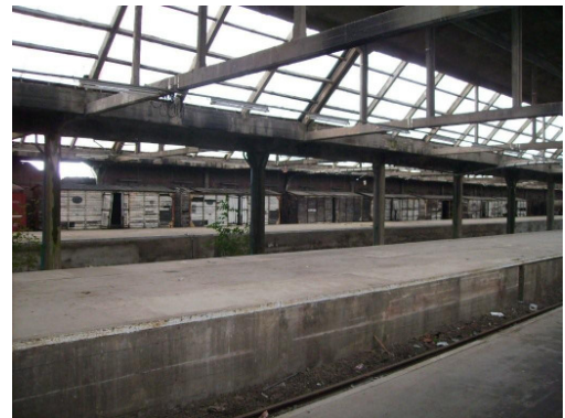
Ehemaliger Güterbahnhof Montzen, fotografiert in 2007
